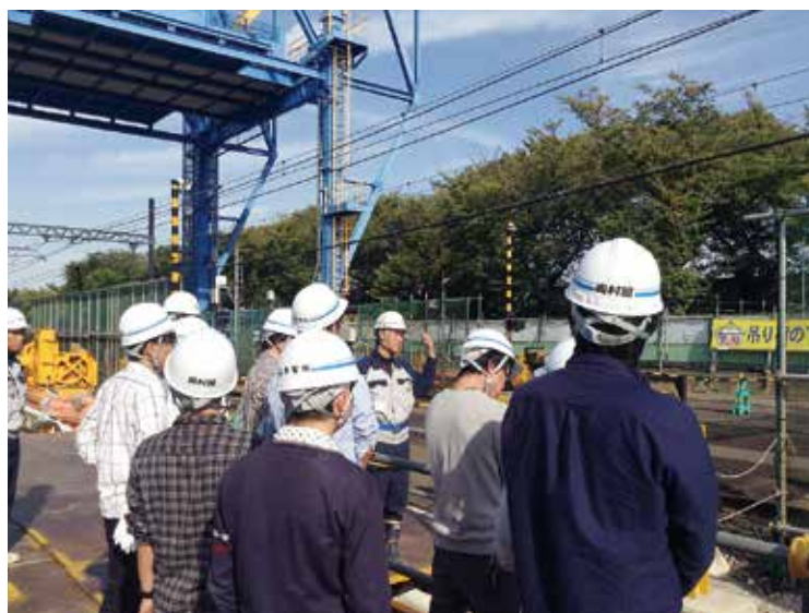
線路脇での現場見学の様子
