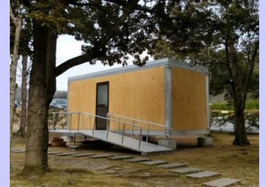
仮設住宅工法
