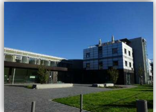
研究所の正面玄関。現在内装工事中のため、今は建物の裏側から出入りしています。
