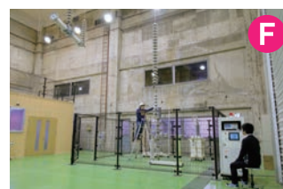
高圧実験室 電気工学の分野の中で、特に高い電圧が加わる所に起きる現象について学ぶ施設です。
