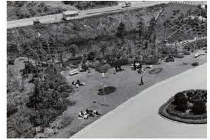
3号館建設予定地 憩いの場となっていた。 （昭和55年）
