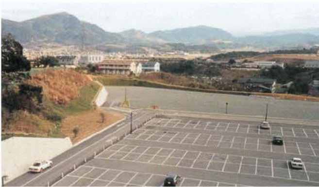
学生第1駐車場後方に第2駐車場造成。(平成8年)
