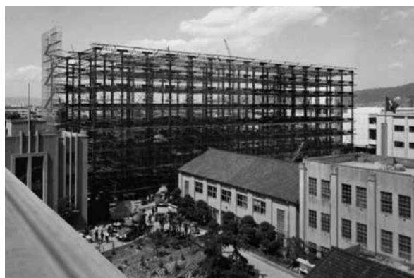
鉄骨が組み上がった21号館
