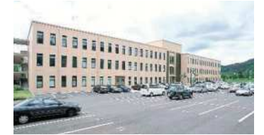
2001(平成13) 東広島キャンパスG館建設
