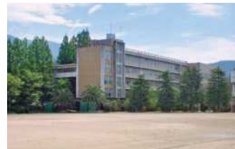
1966(昭和41)5号館建設
