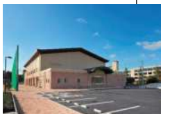
2018(平成30)体育館建設
