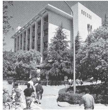
1979(昭和54) 8号館(図書館、講義室)建設
