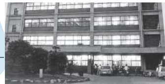
1963(昭和38)4号館建設
