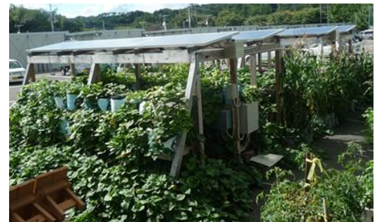
図3. ソーラーシェアリング多層栽培システム設備
