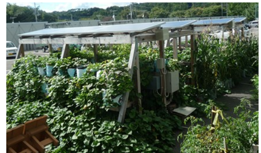
図3. ソーラーシェーディング多層栽培システム設備
